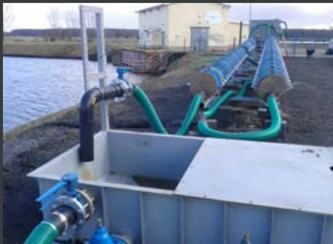
Widok instalacji od strony wylotu z systemu
