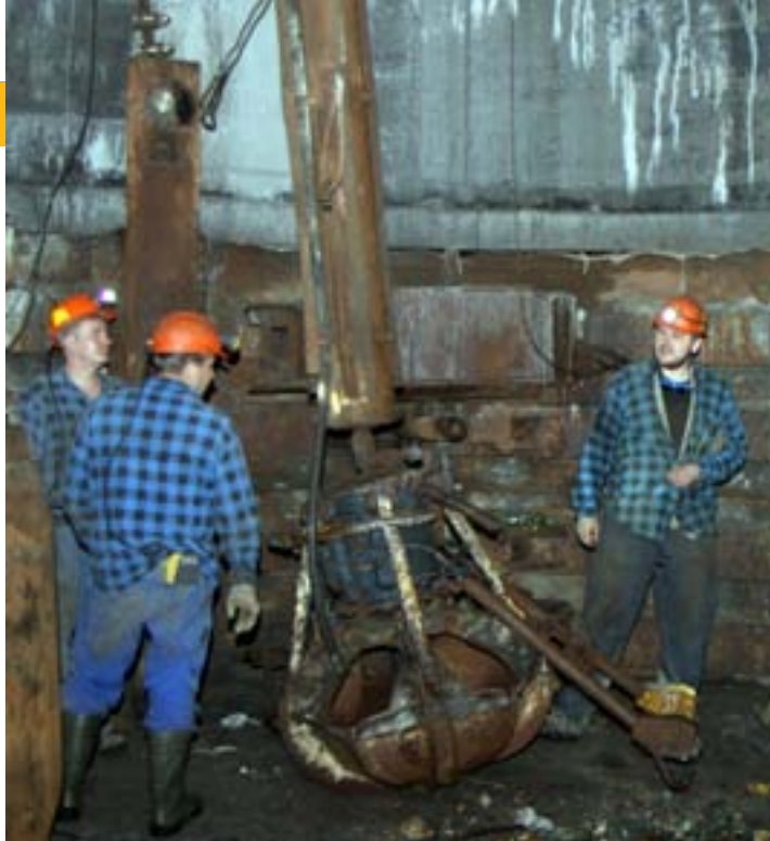
W ostatnim czasie, po ukończeniu prac związanych z zabudową niezbędnej infrastruktury na poz. 880 m, zakończonych pozytywnymi odbiorami górniczych wyciągów szybowych ponownie ruszyły roboty górnicze związane z dalszym pogłębianiem na dnie szybu 8 na poz. 923 m. FOT.: Jan Czy pionka
