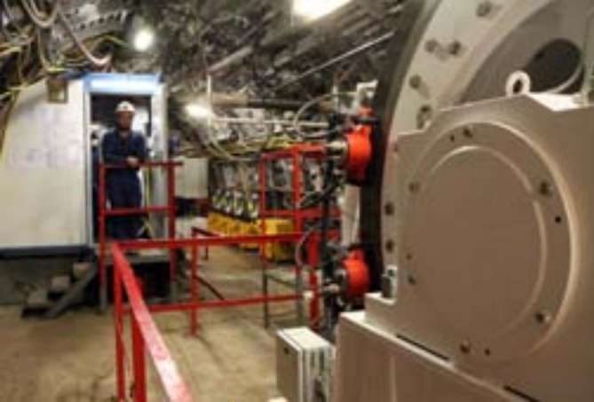
Prace związane bezpośrednio z realizacją pogłębiania szybu 8 rozpoczęto w sierpniu 2013 roku od zabudowy niezbędnych maszyn i urządzeń (zabudowano między innymi 2 maszyny wyciągowe B-2000 Wolff i B-2000 AC oraz wciągarki wolnobieżne typu KUBA-10). FOT.: Jan Czipionka
