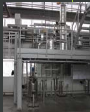
Laboratoryjna instalacja bezpośredniego upłynnienia węgla w CCTW GIG
