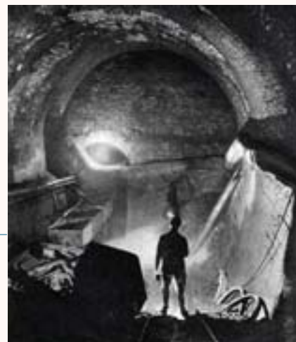
Budowa komory pod ziemią – lata 50. XX w. FOT.: ARC
