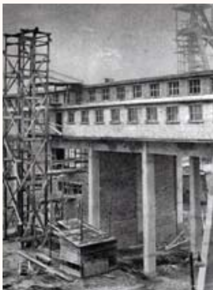
Budowa lampowni – lata 50. XX w. FOT.: ARC
