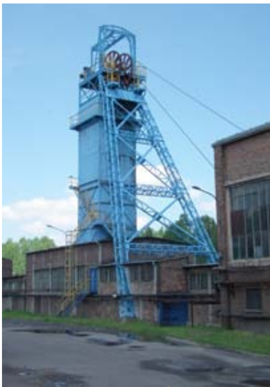
W rejonie szybu „Wacław” zbudowana ma zostać podsadzakownia. FOT. Wojciech Jaros
