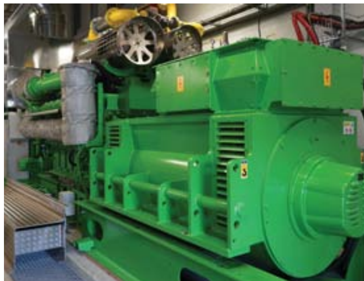
Agregat napędzany jest gazem z odmetanowania kopalni, który do tej pory uwalniany był ze stacji odmetanowania do atmosfery. FOT.: Jan Czipionka
