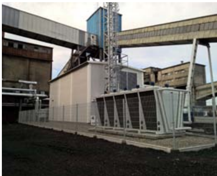
W związku z realizacją inwestycji, wykonano szereg koniecznych prac adaptacyjnych, szczególnie w obrębie rozdzielni elektroenergetycznych oraz w obejściu nowego budynku silnika. FOT.: ARC
