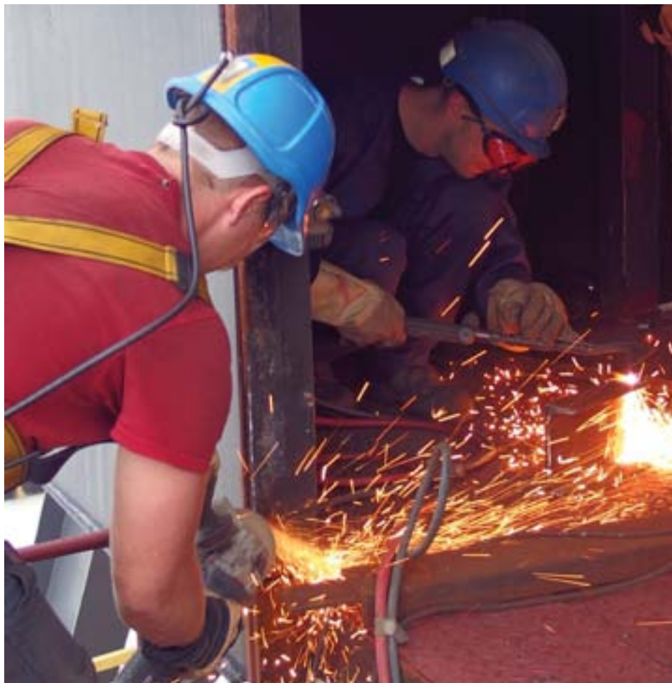
Pracownicy oddziału szybowego Daniel Puda i Adrian Łajczak w trakcie prac związanych z wymianą uszczelnień wewnętrznych wieży szybowej szybu III w kopalni „Piast-Ziemowit” ruch „Piast”.
