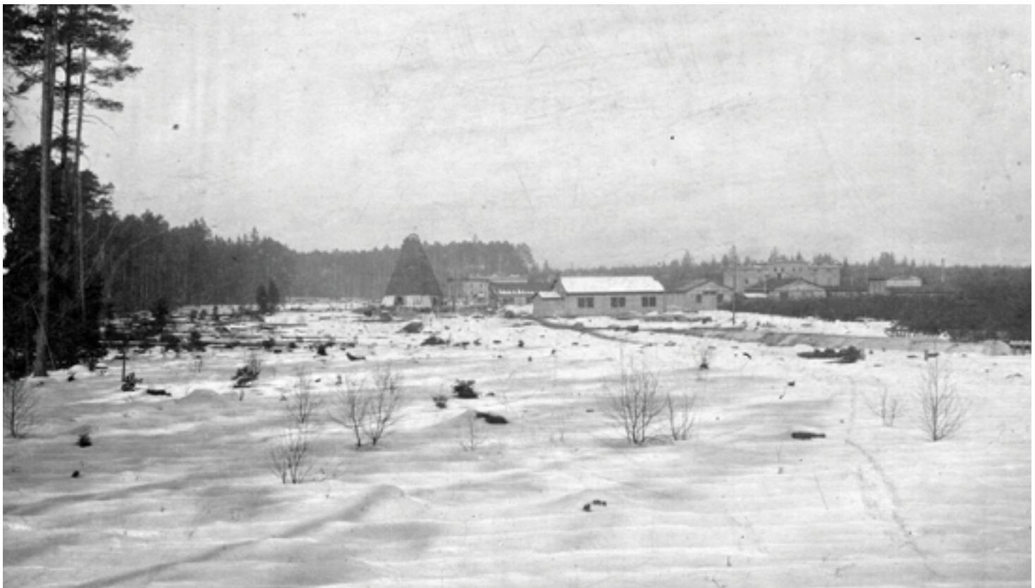
Jako plac budowy przyszłej kopalni obrano zachodnią granicę obszaru leśnego „Judasz” (Judasforst). W pierwszej kolejności wybudowano stację rozdzielczą, do której z kopalni „Donnersmarck” dostarczono dwoma kablami energię elektryczną. Zdjęcie z roku 1915.
