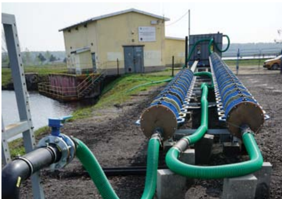
Instalacja składa się ze stanowisk modułowych, z zeolitem umieszczonym w specjalnych kartridżach z tworzywa sztucznego.
