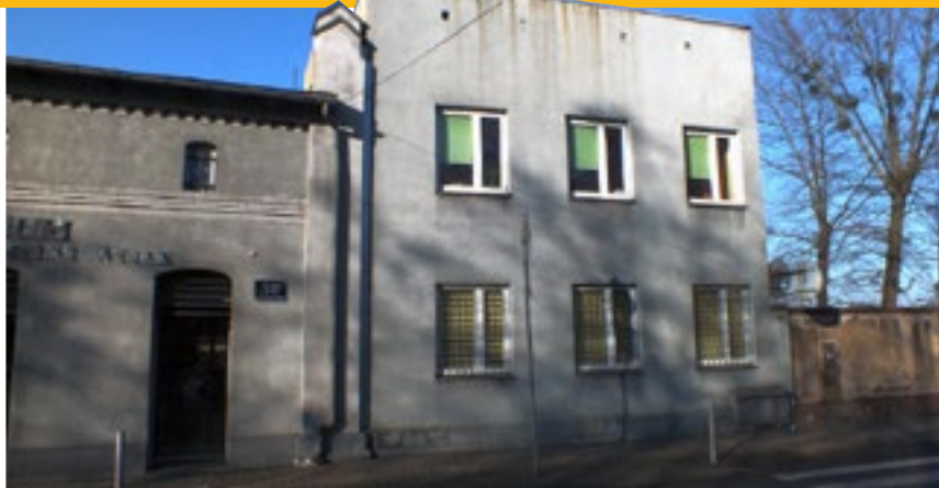
BUDYNEK ŁAŹNIA PAROWEJ, FOT. ŚCWIS
