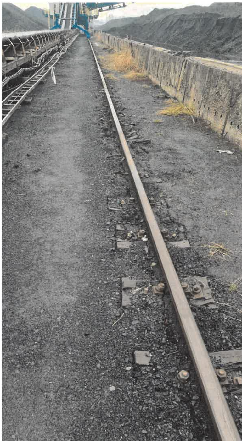
Rys 4. Widok torowiska -tor prawy
