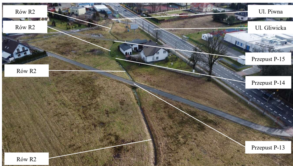
Fot. 8. Rów R2 pomiędzy ulicą Polną a ulicą Piwną (autor M. Gabzdyl)
