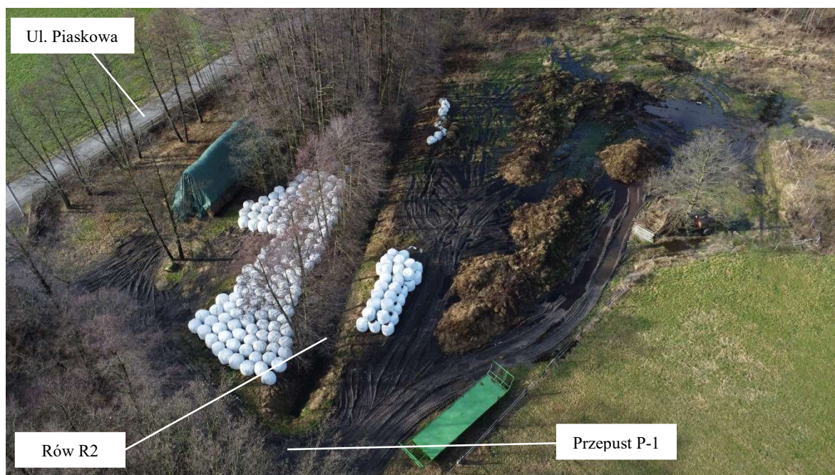
Fot. 2. Odcinek rowu R2 pomiędzy ujściem a przepustem P-1 (autor M. Gabzdyl)
