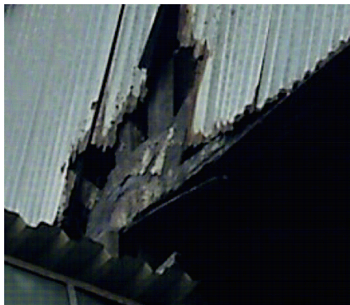
Zdjęcie 5 – środkowa część mostu od strony zachodniej – widoczne znaczne ubytki obudowy z blachy trapezowej oraz znaczna korozja konstrukcji stalowej w rejonie odsłoniętych węzłów
