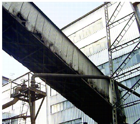
Zdjęcie 2 – widok od strony południowo-zachodniej – dolna część mostu 1.12
