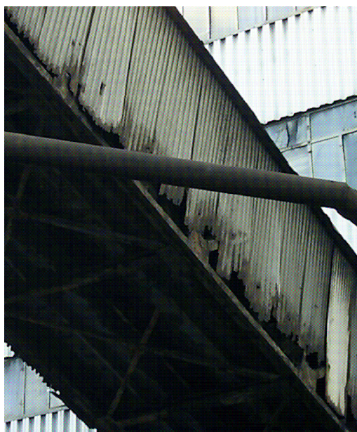
Zdjęcie 5 – środkowa część mostu od strony zachodniej – widoczne znaczne ubytki obudowy z blachy trapezowej oraz znaczna korozja konstrukcji stalowej w rejonie odsłoniętych węzłów
