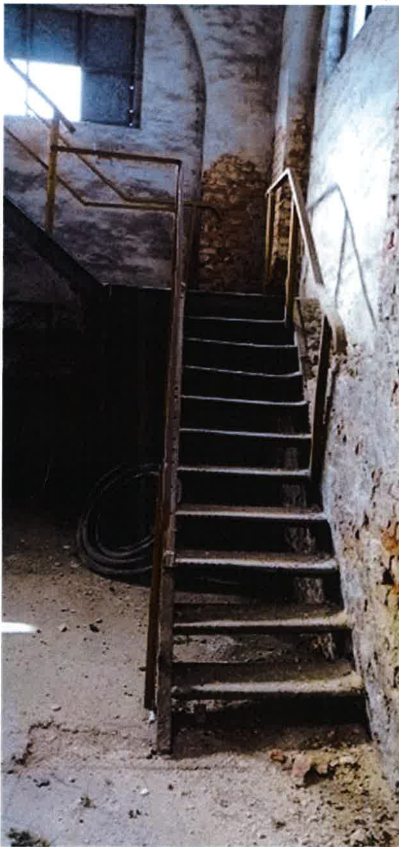
Fot. 8. Konstrukcja schodów stalowych
