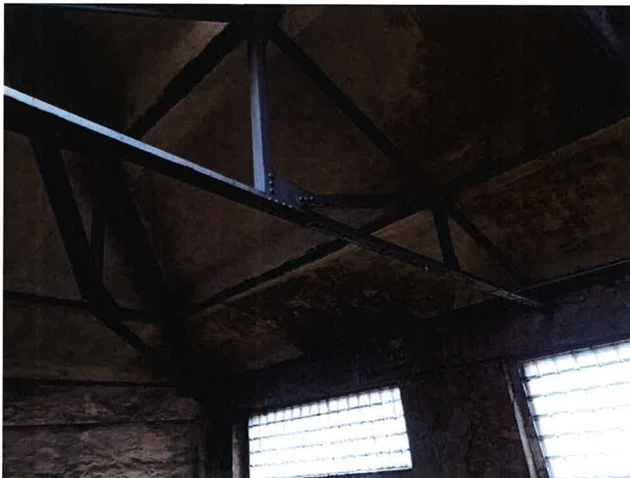
Fot. 21. Złuszczone powłoka antykorozyjna konstrukcji stalowych
