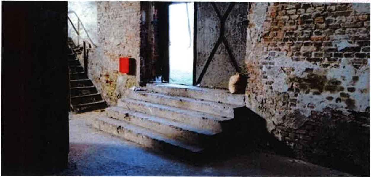
Fot. 5. Konstrukcja schodów wejściowych
