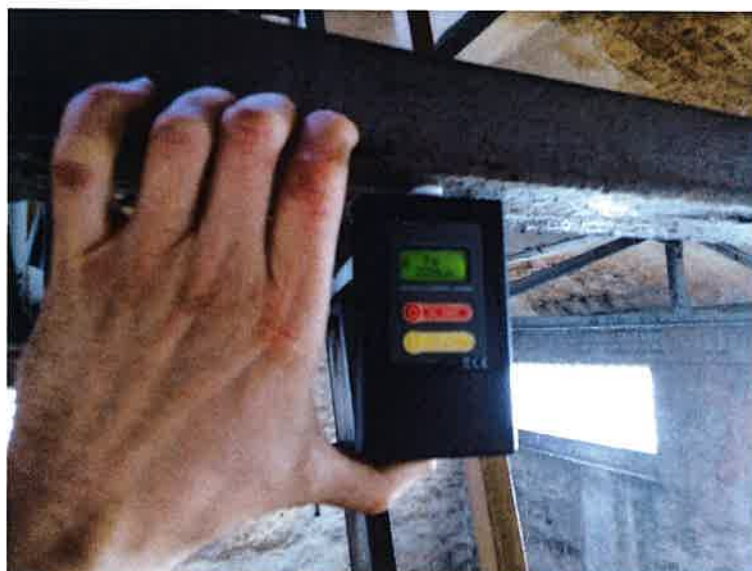
Fot. 1. Przebieg badania grubości powłok malarskich.
