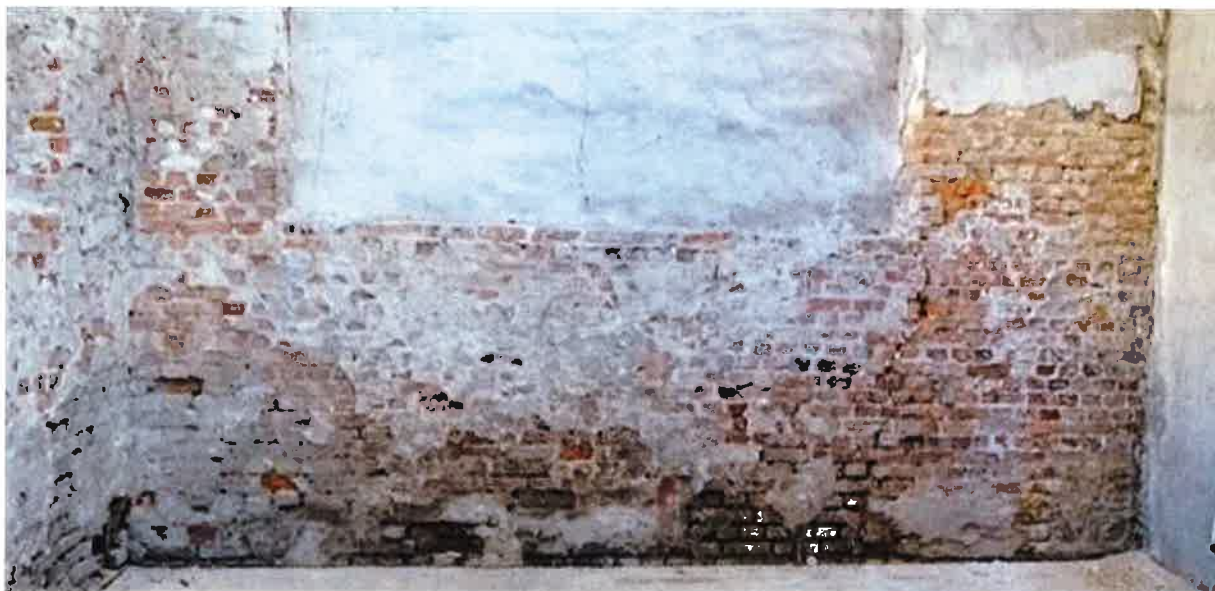
Fot. 12. Fragment ściany zewnętrznej
