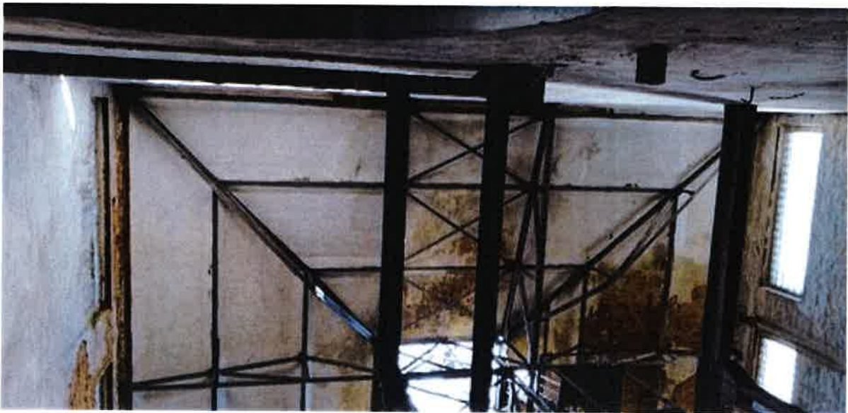
Fot. 10. Konstrukcja dachu
