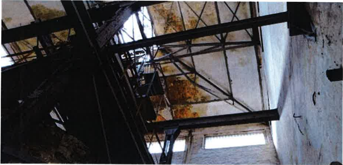
Fot. 9. Konstrukcja stalowego podestu komunikacyjnego
