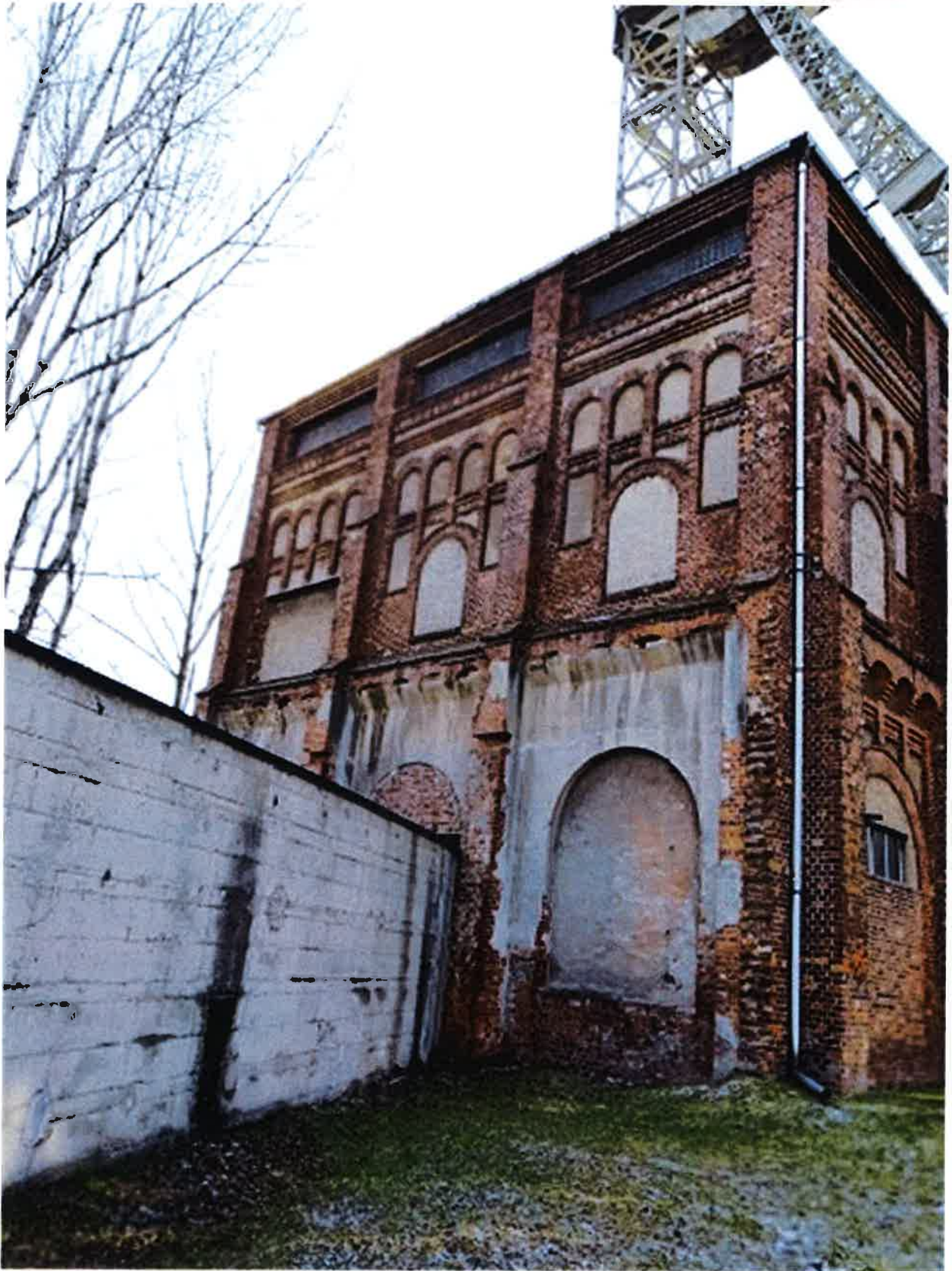
Fot. 4. Widok budynku od strony północnej
