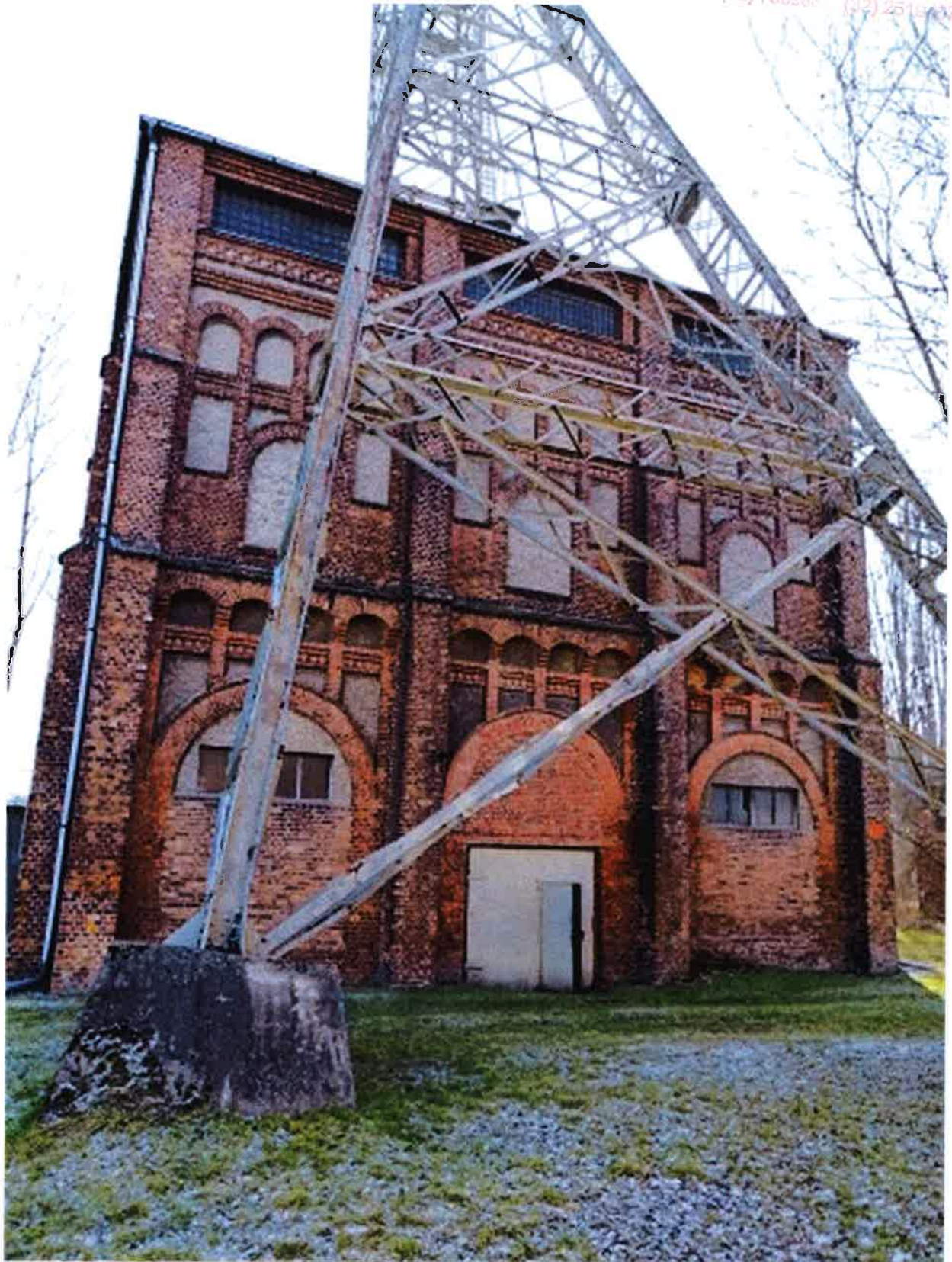
Fot. 3. Widok budynku od strony zachodniej
