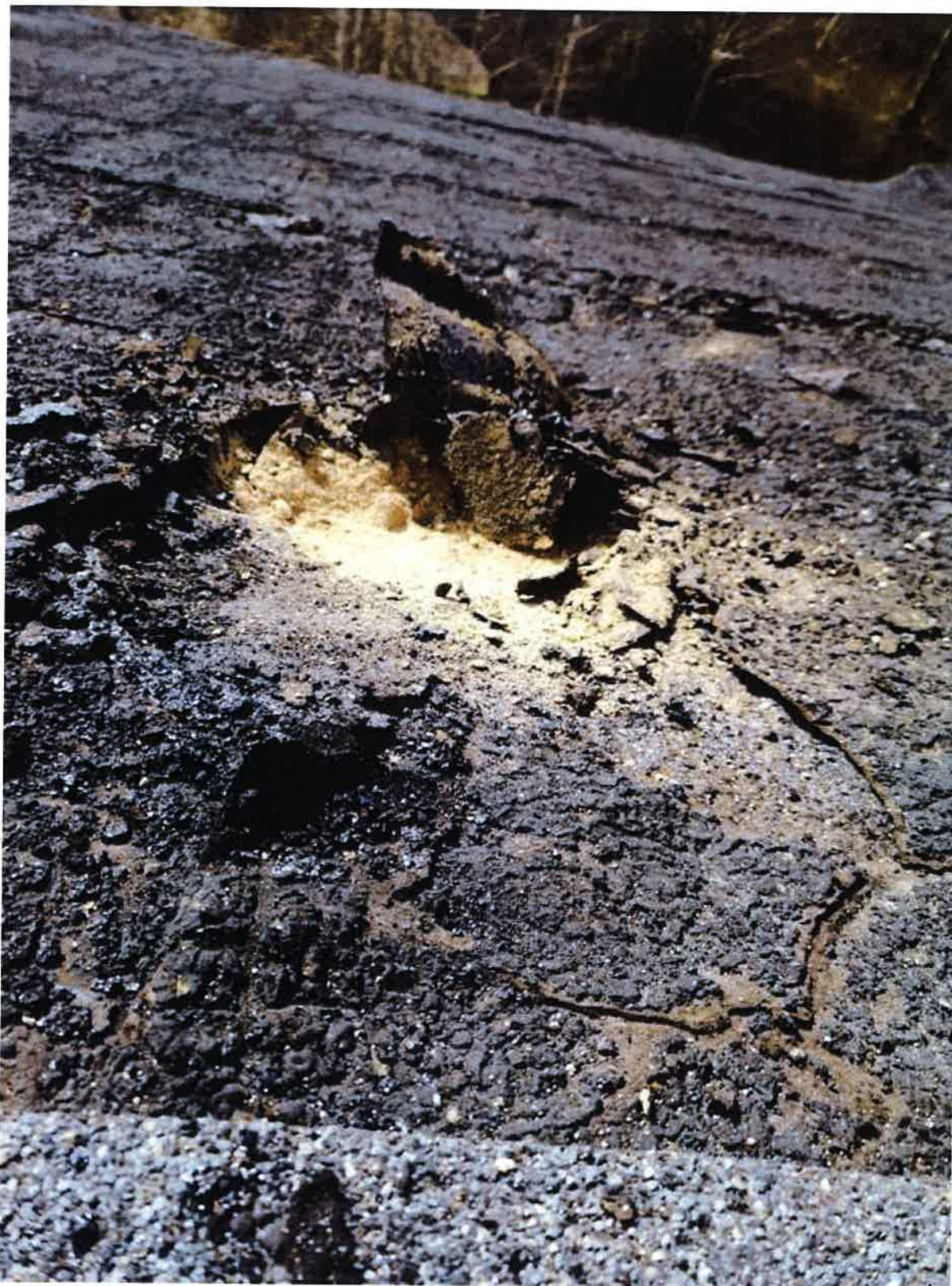
Fot. 17. Warstwa wyrównawcza pod pokryciem dachowym – papą bitumiczną
