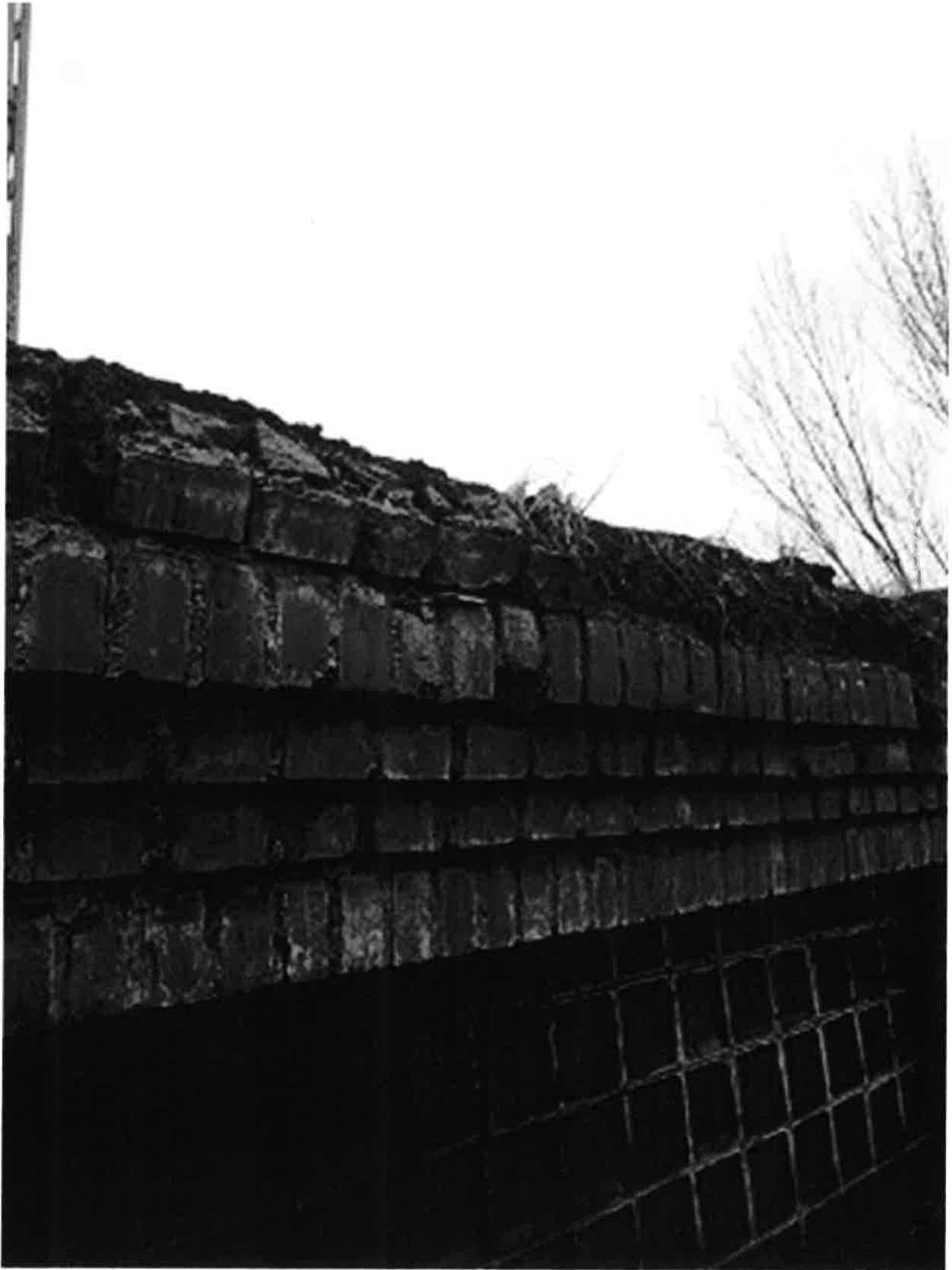
Fot. 18. Uszkodzony i brakujący gzyms
